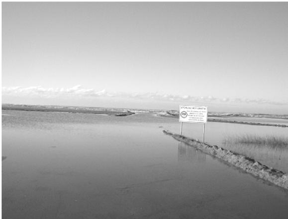
**Figura 2:** Represamento das águas pelas barreiras de canalização do fluxo veicular
